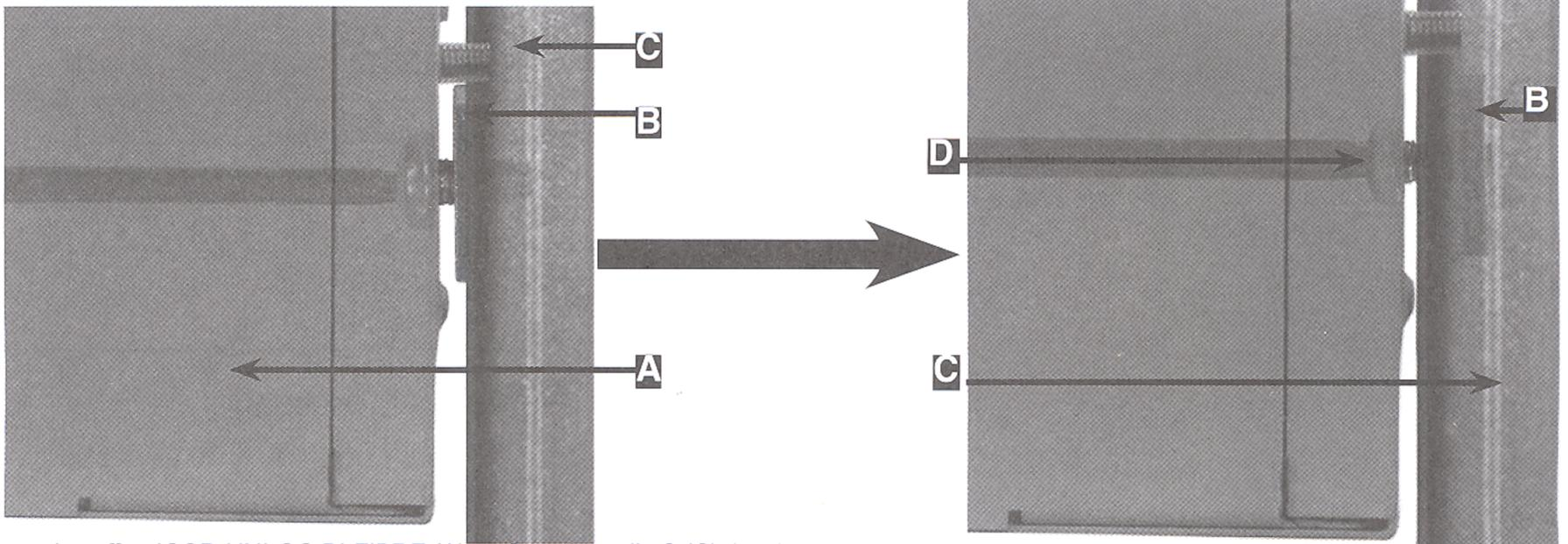
Placer le coffret ICOR-UNI-OC-BI-FIBRE (A) en face des rails C (C), les 4 platines écrous (B) doivent être intercalées dans les 2 rails C (C).
